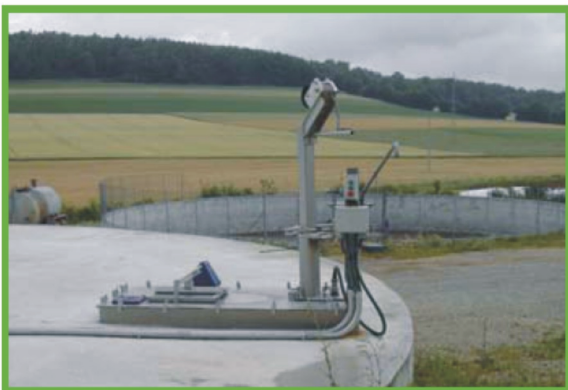
s betonovým stropem
